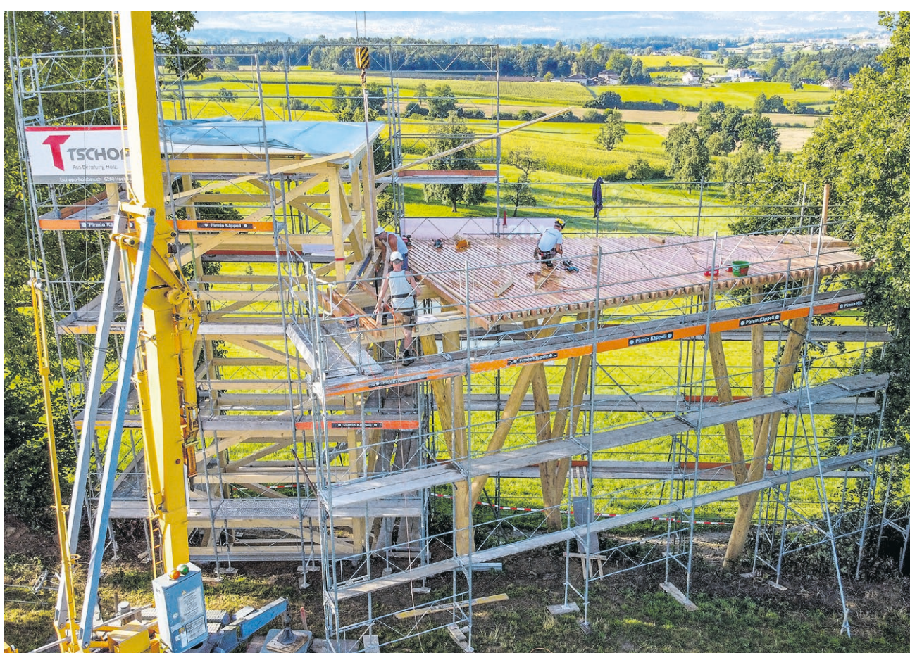
Die Grundstruktur ist bereits klar zu erkennen: Links der Turm, in welchem dereinst die Treppen nach oben führen werden; rechts, getragen von den massiven Rundhölzern, die Aussichtsplattform.
