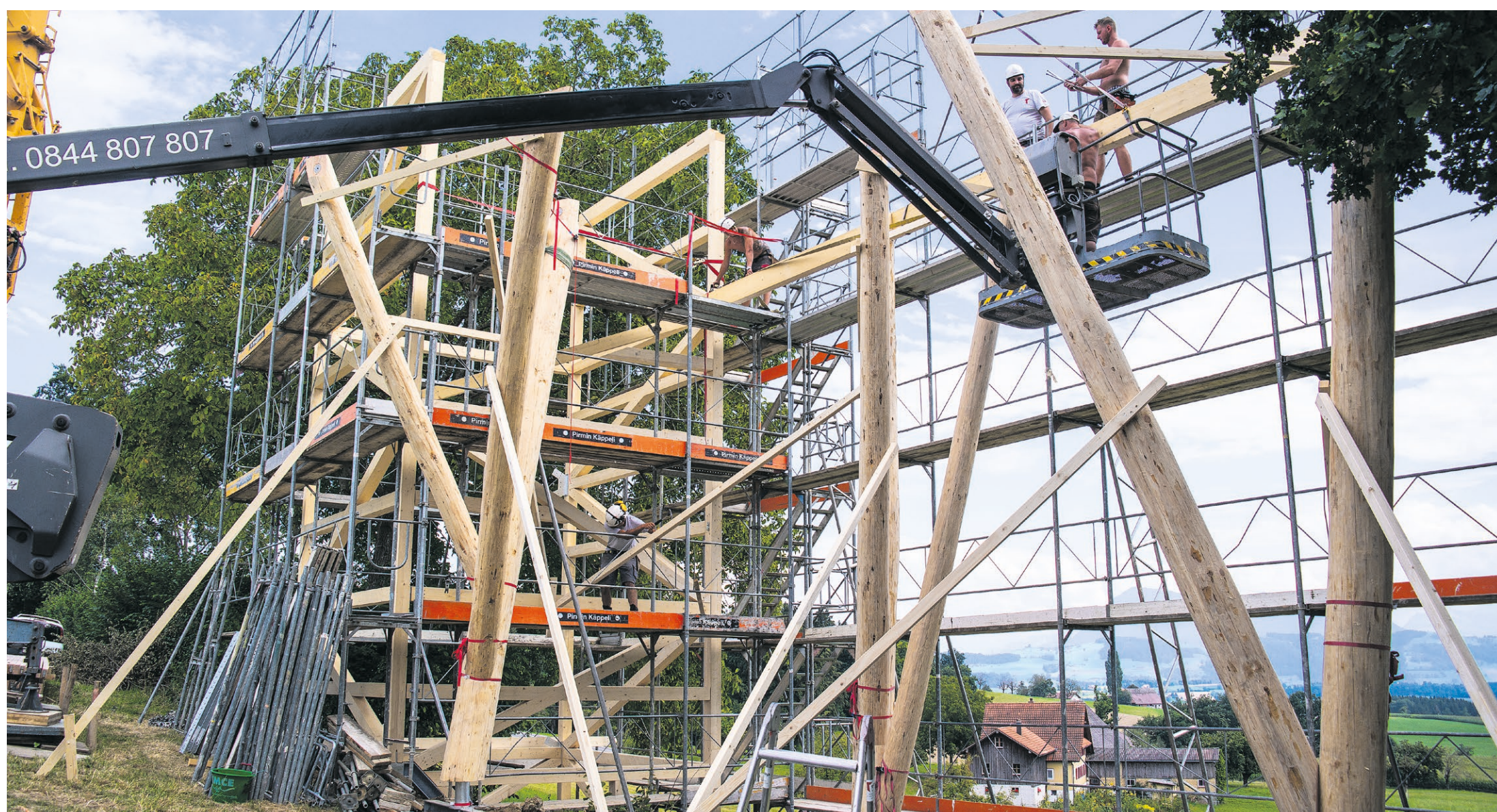
Die Arbeiten am Turm kamen vergangene Woche schneller voran als geplant. Fotos Claudio Brentini
